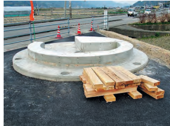
①へんろ小屋の基礎ができたところです。
